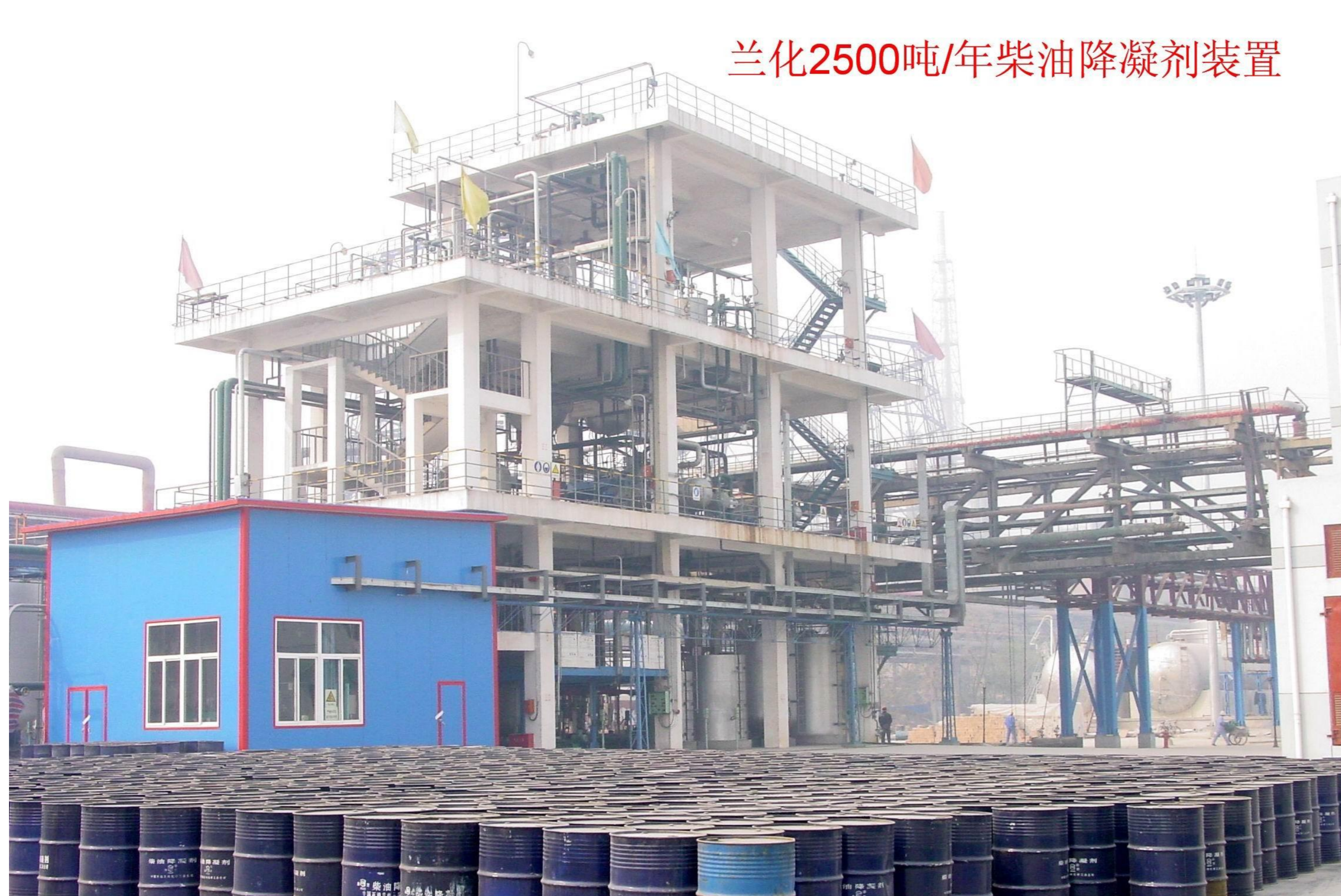
兰州石化2500吨/年降凝剂生产装置
